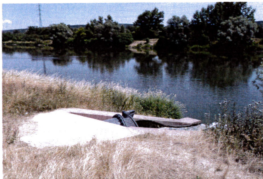
Obr. 5.10 Pohľad na existujúci výpustný objekt SOCOMANU. Prilahlý brehový úsek vytipovaný pre umiestnenie vyústenia z nového výsledného kanalizačného zberača odpadových vôd z NJZ JB (Fotené z obslužnej cesty na pravej strane vedľa Drahovského kanálu)
